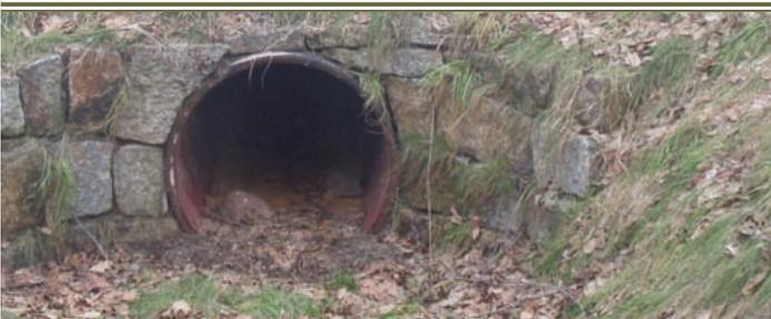
Fischotterdurchlass: Der Otter stellt keine hohen Ansprüche an Querungshilfen. Ein einfaches Rohr in Kombination mit einem kurzen Leitzaun ist völlig ausreichend.
